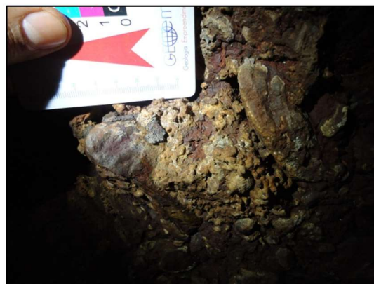
Figura 112: Crosta de óxido-hidróxido na parede.
