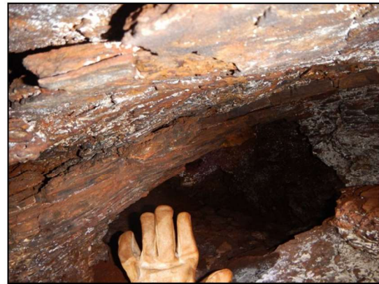
Figura 88: Entrada de conduto interno. Notar a formação ferrífera e crosta branca.
