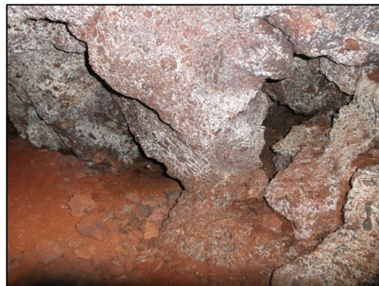
Figura 92: Detalhe de pilar da cavidade existente próximo ao canal ligado à clarabóia.
